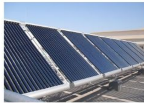
太陽熱集熱設備の設置イメージ
